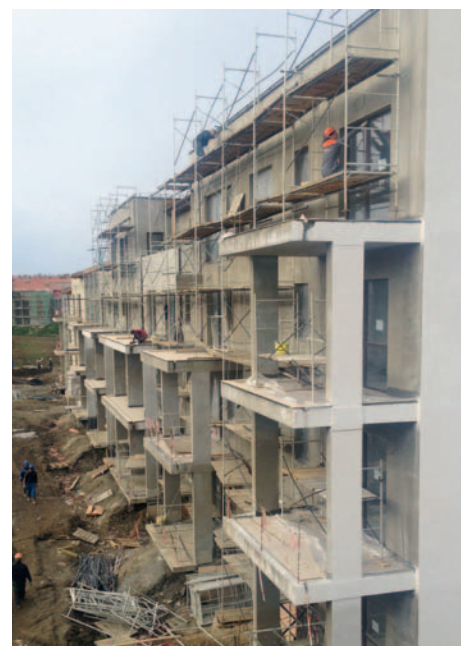
Village olympique: Sotchi est encore en chantier.
