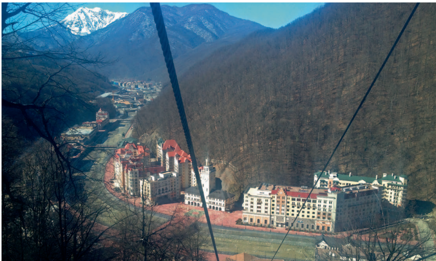
Rosa Khutor: au total 400 projets de construction en total sont à terminer jusqu'au début des Jeux l'année prochaine, comme ici le long de la rivière Msynta.
